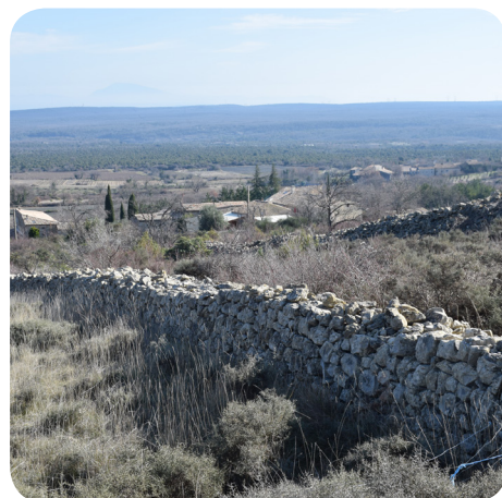
Réseau de murets en pierre sèche
