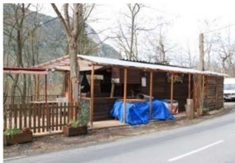
Le restaurant implanté en bord de route pose des problèmes de sécurité
