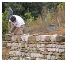
Calcaire assisé régulier
