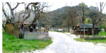
Bâtiments d'accueil des clients, vétustes et à l'aspect bricolé, ne participant pas à donner une image positive de l'activité
