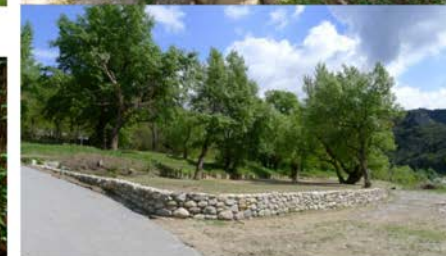
Réinterprétation des systèmes des terrasses de pierre sèche au sein du camping de la Rouvière
