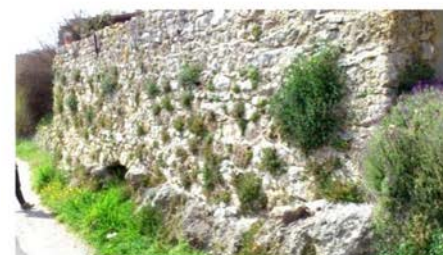
Mur de soutènement, servant aussi de clôture dans le village de Chames
