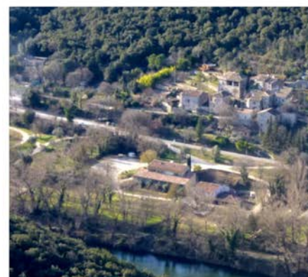
Espaces boisés et de prairies entourant le domaine, participant à l'insertion paysagère du bâtiment, mais forte présence des étendues de stabilisé des parkings et voies de desserte depuis le point de vue du Serre de Tourre
