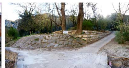
Traitement de la pente par de nombreux talus artificiels et des enrochements
