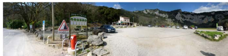
Parking de l'Auberge du Pont d'Arc fortement impactant dans la Combe d'Arc, par son emprise et son positionnement
