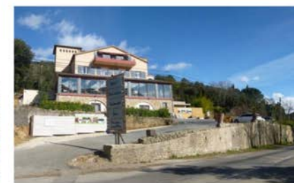
Entrée de l'hôtel dominée par l'espace du parking et la présence du mur de soutènement massif
