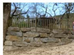
Mur de soutènement composé d'enrochements maçonnés
